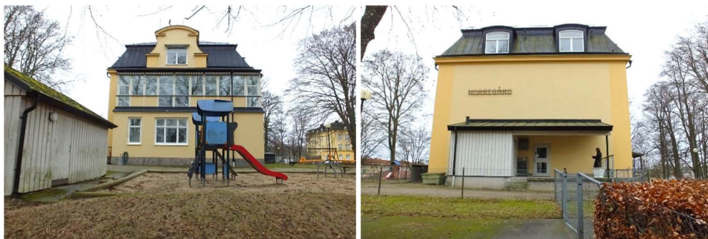
Sjukhusets södra respektive norra fasad.
