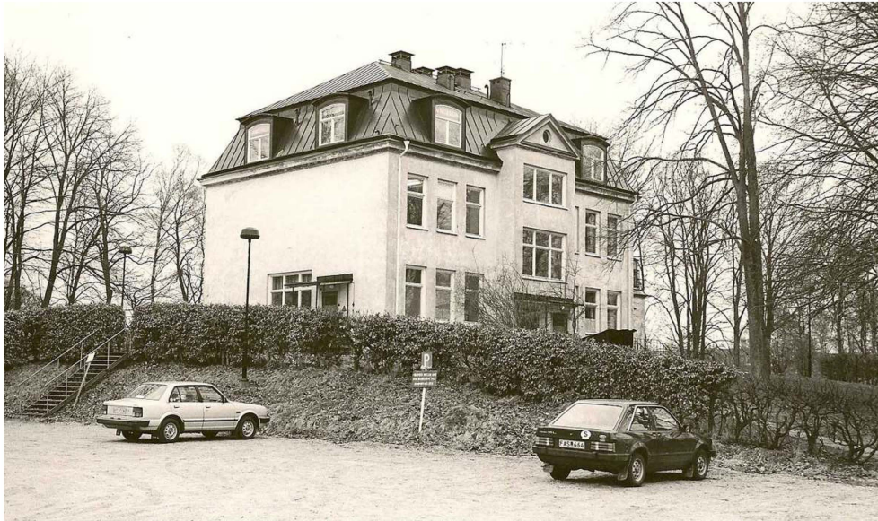
Sjukhuset sett från nordväst sedan det byggts om i slutet av 1970-talet för delvis ny verksamhet. Fotografi från Västra Göinge hembygdsförening.
