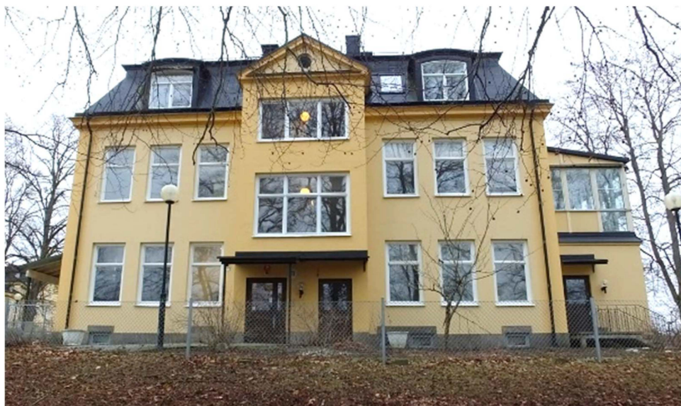
Sjukhusets västra fasad.
