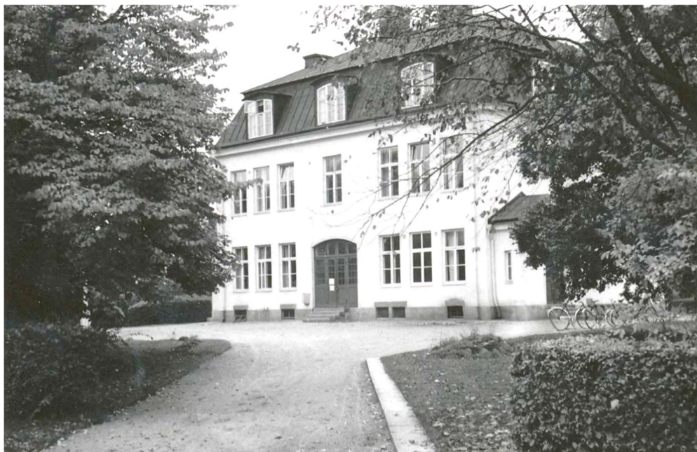
Sjukhusbyggnaden sedd från nordost. Förutom höga träd ses klippta häckar på var sida om vägen fram till entrén. Fotografi från Västra Göinge hembygdsförening.
