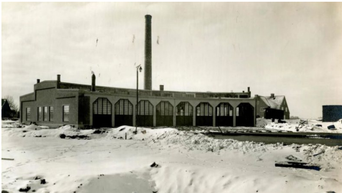
Figur 12 Lokstallet när det var nybyggt.
