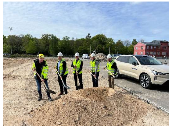
Den 8 maj togs första spadtaget för nybyggnad av Smarta lokaler på fastigheten Tanken 9. Foto: HIBAB
