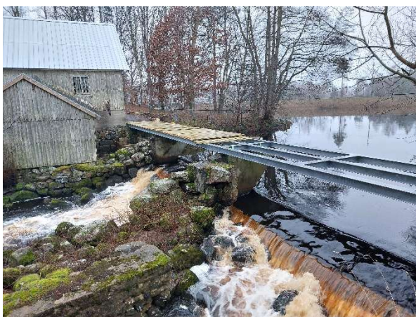
Renovering av gång- och cykelbron vid Vittsjö Kvarn. Foto: Thomas Johansson
